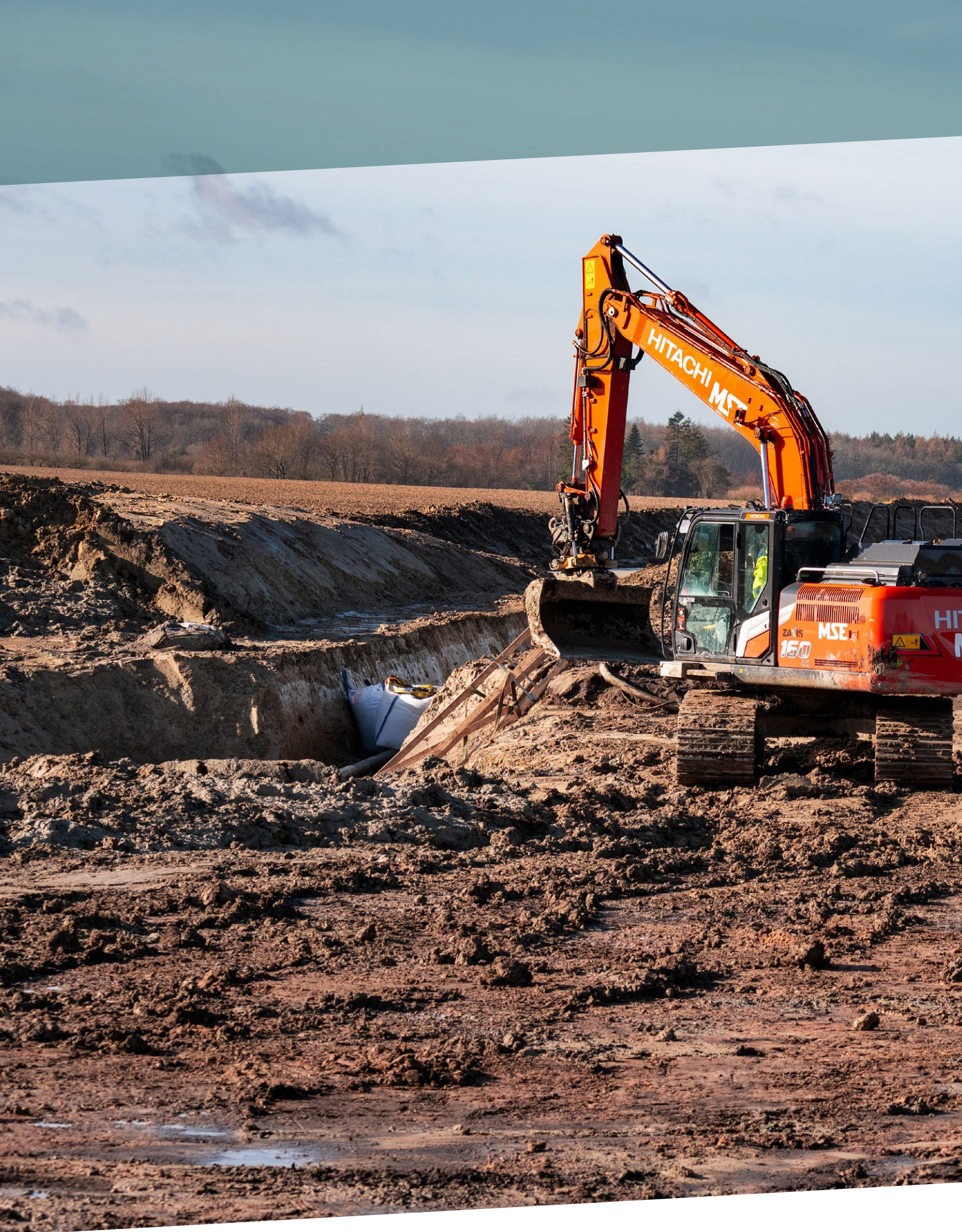
Foto: Gasledning nedgraves - Jens Larsen, Nakskov Fotogruppe
